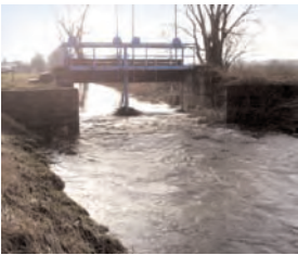
Fuhsewehr Wilhelmshöhe Vor Rückbau 1996
