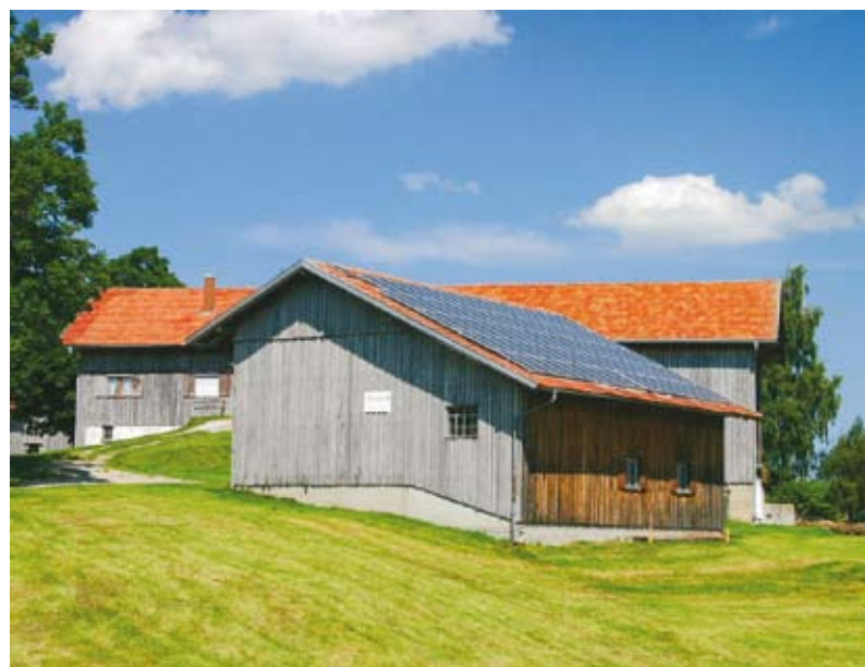
Besonders gute Einstrahlungsbedingungen gibt es im Süden Deutschlands. Große unverschattete Dächer von Bauernhöfen eignen sich optimal für Photovoltaikanlagen. Foto: Volker Quaschnig
