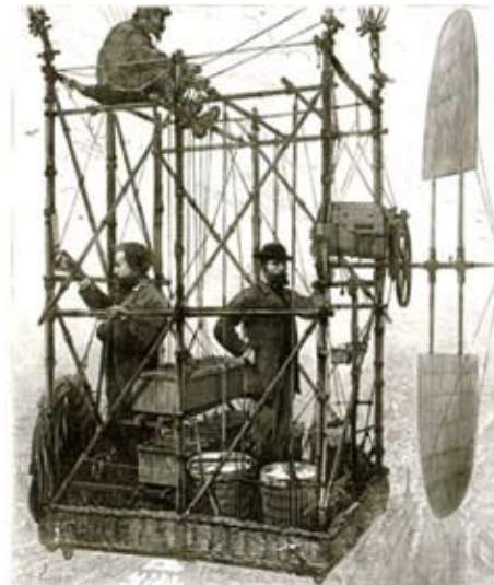
Links: das Luftschiff der Brüder Tissandier; rechts: dessen Gondel mit den Batterien und dem Siemens-Motor.
